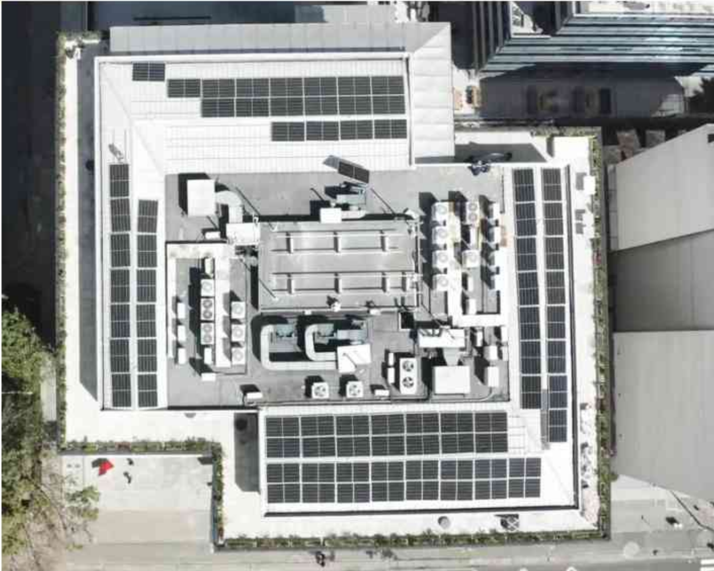
Adidas - 61.2 Kwp - Bogotá D.C.
